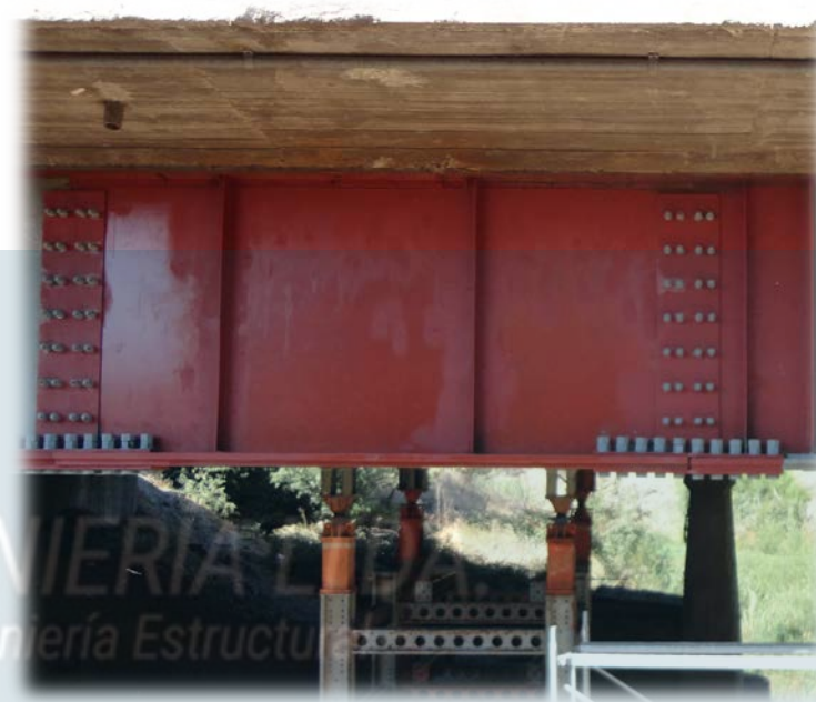
Estado final de la reparación antes de la pintura de protección.
